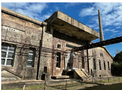
針尾送信所電信室と第2号電信塔
