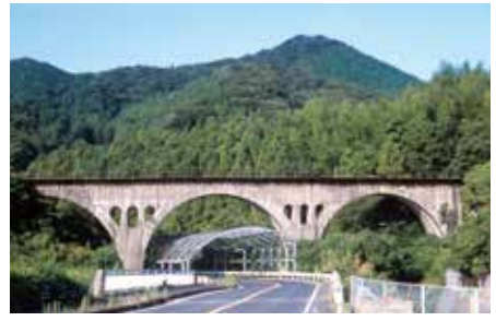
【出典】 福井川橋梁、佐世保市 CCライセンス ( http://creativecommons.org/licenses/by/4.0/deed.ja )
